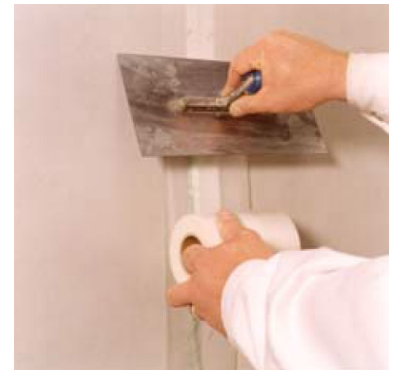
Aplicación de la cinta de Refuerzo para juntas fermacell HD
